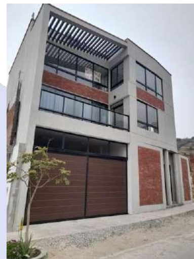
EDIFICIO BI FAMILIAR PACHACAMAC
